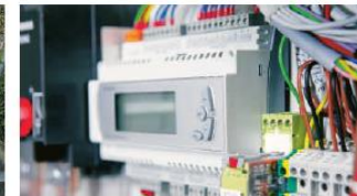
Elektronische Steuerung und elektronische Expansionsventile. Höhere Zuverlässigkeit, höhere Energieeffizienz.
