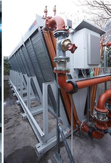
Rückkühler in V-Form mit drehzahlregulierten Lüftern, 560 kW
